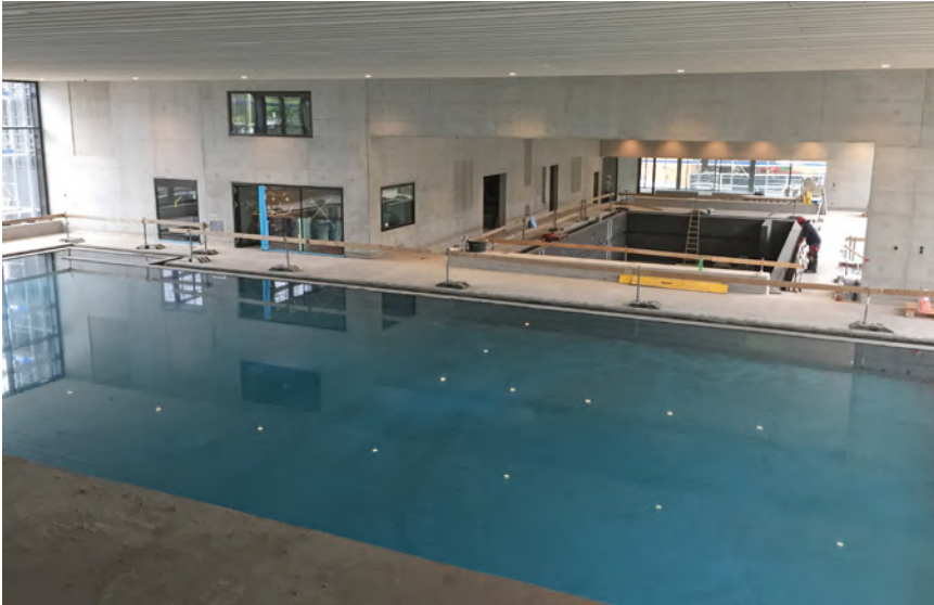
Alle drei Becken werden nach Abschluss der Bau- und Fugenabdichtungen einer Testwasserung unterzogen. Der Test verläuft positiv.
