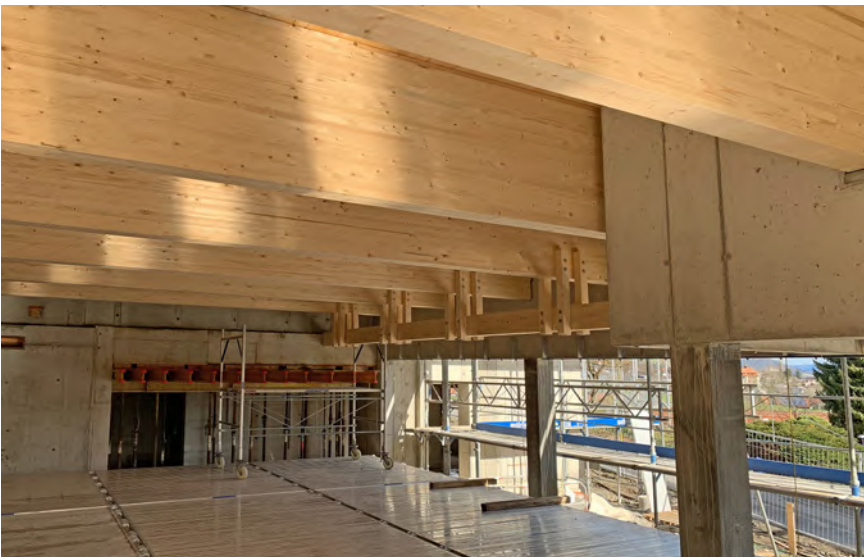
Nebst Beton wird auch viel Holz verbaut. Das Holz der Fassade wurde in der Region geschlagen. Das Dach wurde im März 2020 fertig gebaut.
